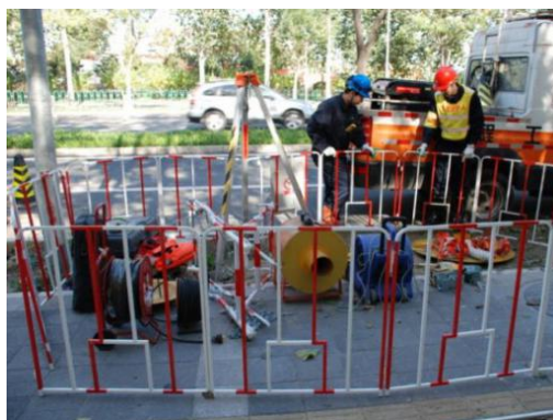
图 4-2 作业现场围挡
